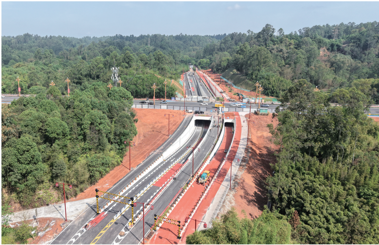
绿心下穿隧道。
