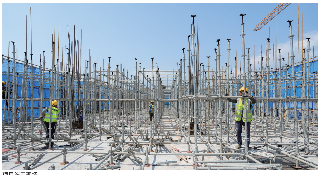
项目施工现场。
