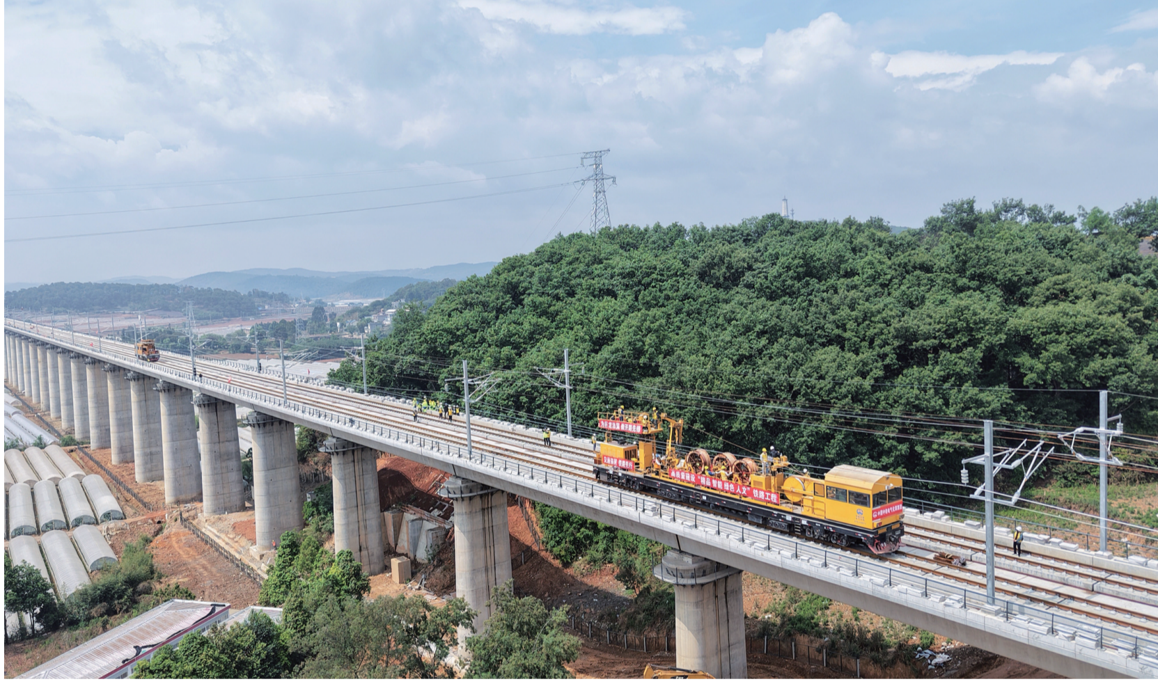
4月28日,渝昆高铁云南段全线首条接触网导线架设任务顺利完成,标志着渝昆高铁云南段正式进入全线接触网导线架设阶段。图为当日拍摄的渝昆高铁云南段首条接触网导线架设作业现场(无人机照片)。
