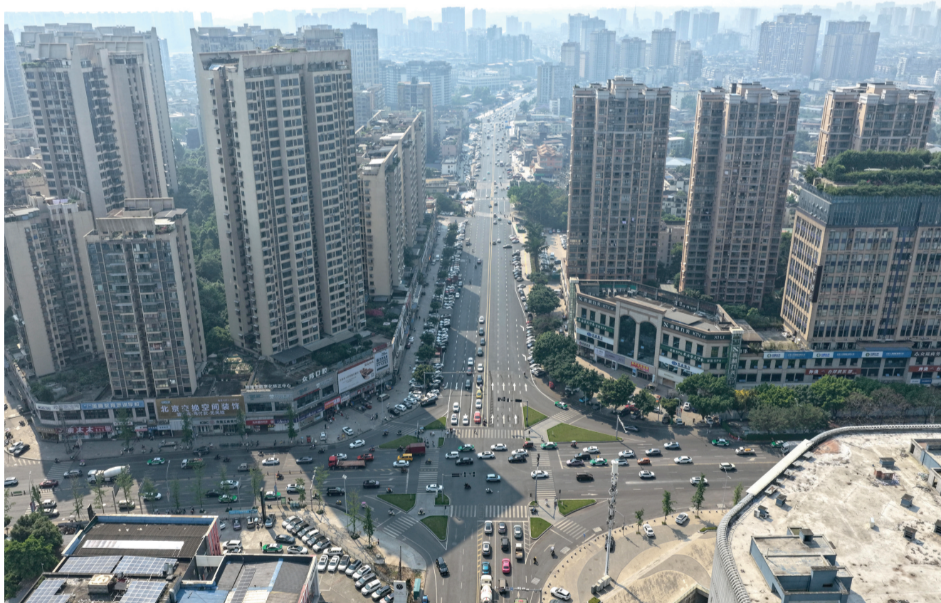
龙游路项目一期已全线贯通。
