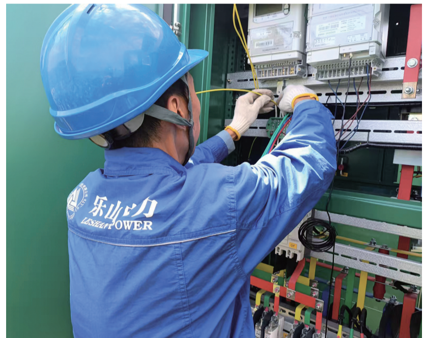
工人在低电压整治现场安装配电箱计量装置。
