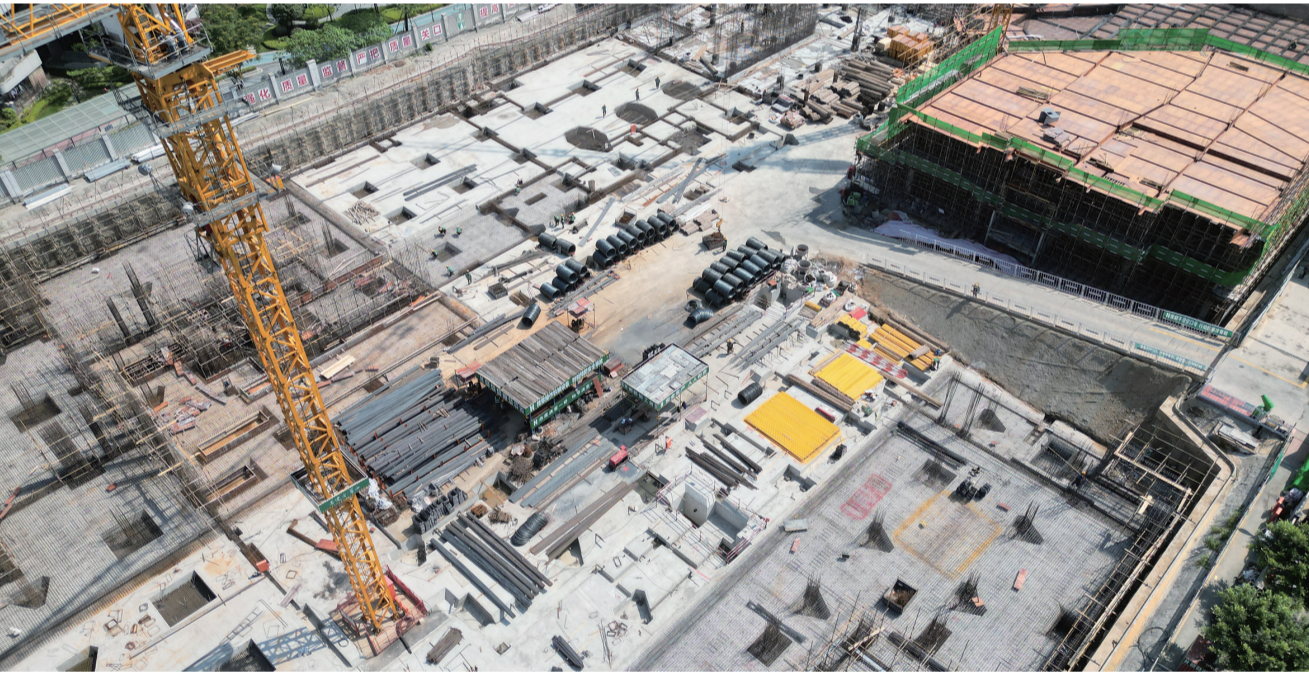
项目施工现场。
