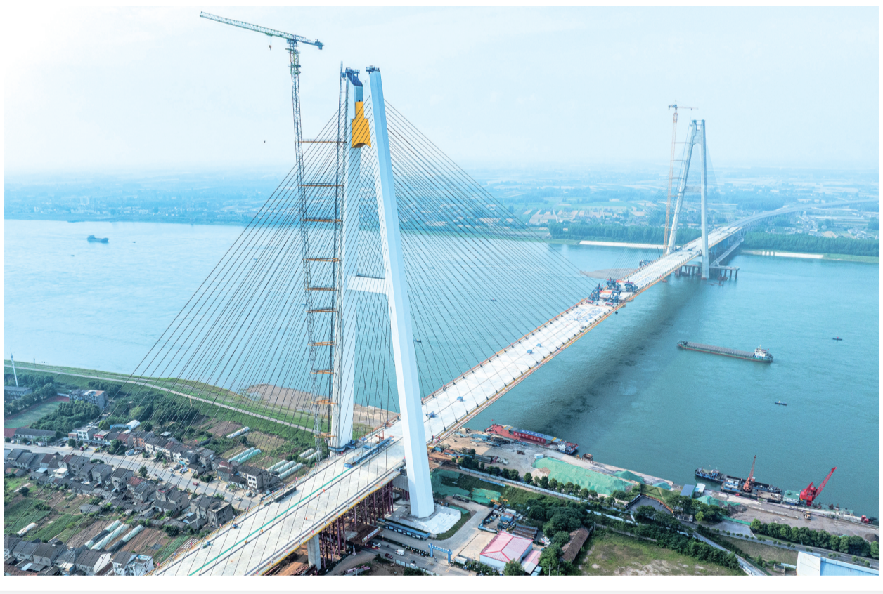
5月15日,由湖北交投集团投资、蜀道集团四川路桥和中交二公局联合承建的枝江长江大桥施工现场迎来关键时刻——随着最后一片钢箱梁精准落位,这座“世界级”斜拉桥在江心完成最后“牵手”,标志着枝江长江大桥顺利合龙,为2026年下半年项目建成通车奠定了重要基础。
