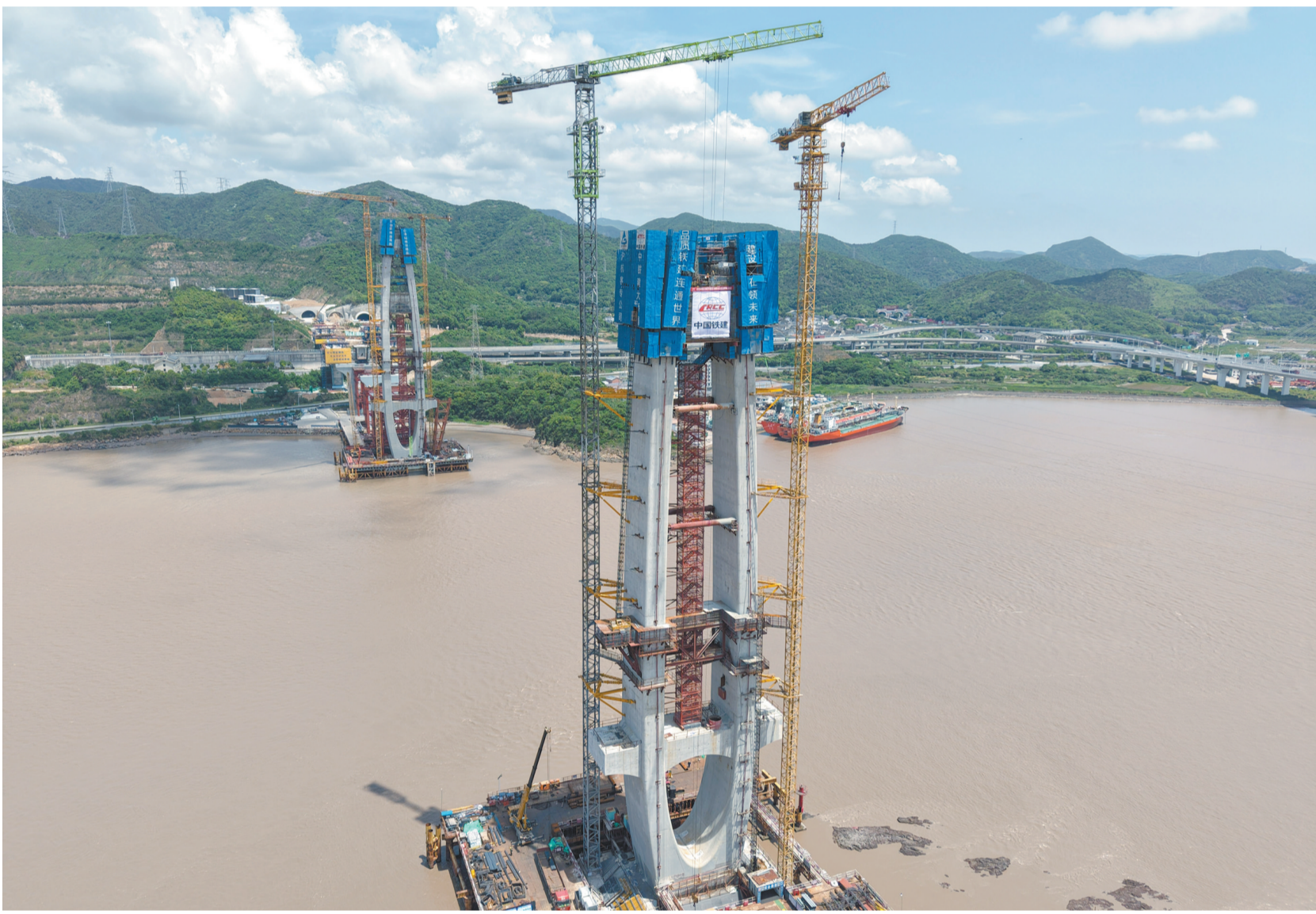
5月17日, 由中国铁建大桥局承建的甬舟铁路富翅门公铁两用大桥西主塔上横梁顺利浇筑完成。富翅门公铁两用大桥连接舟山本岛与富翅岛, 是甬舟铁路的控制性工程之一。大桥全长约1726米, 主跨达388米, 采用双线铁路、6车道高速公路同层布置的形式。图为5月17日拍摄的甬舟铁路富翅门公铁两用大桥西主塔上横梁浇筑现场(无人机照片)。 新华社记者 黄宗治 摄
