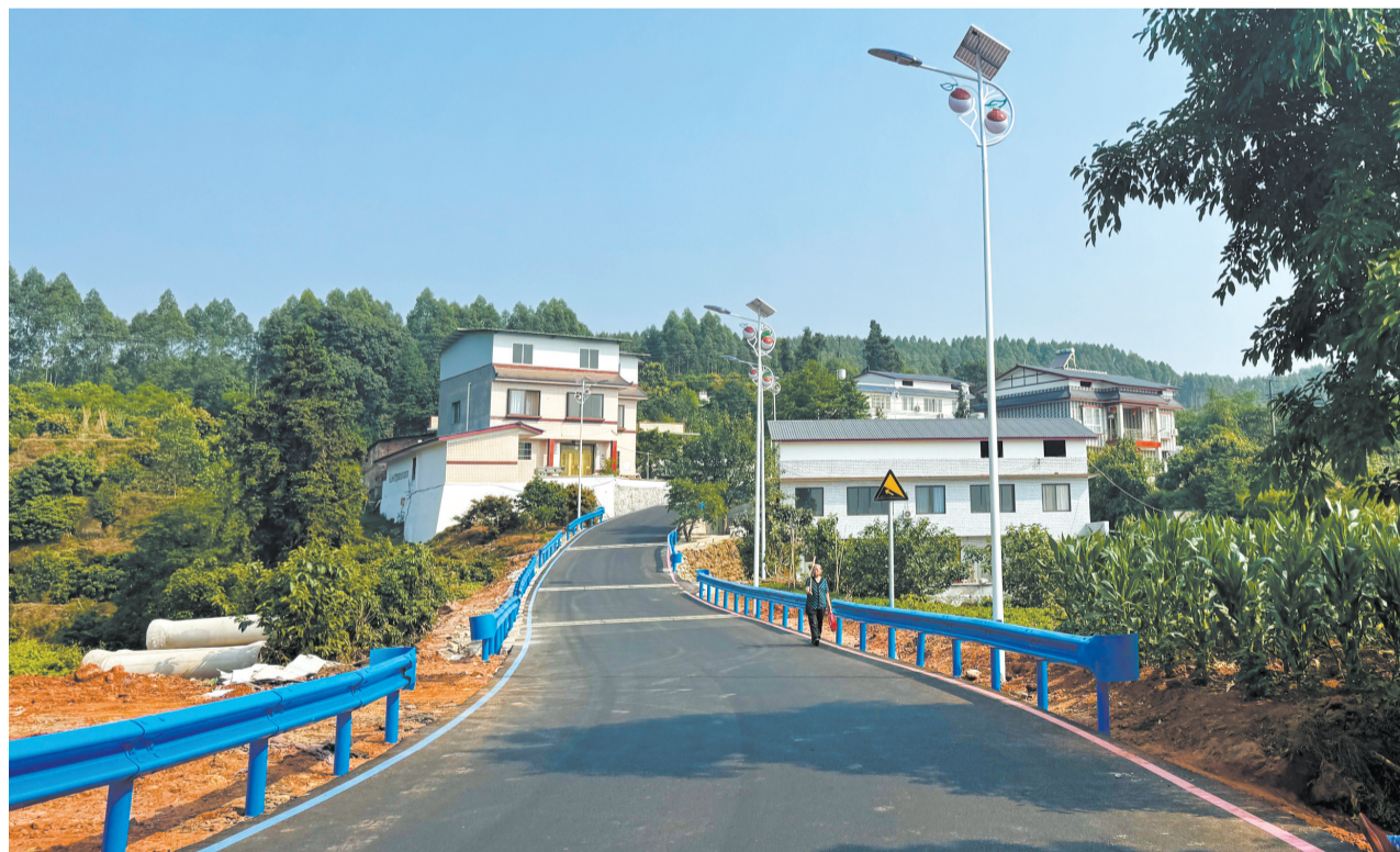
已完工的道路。
