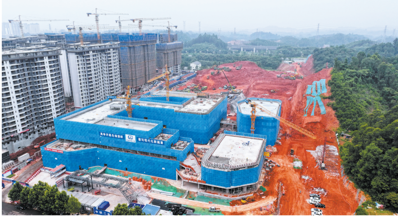
项目建设现场。
