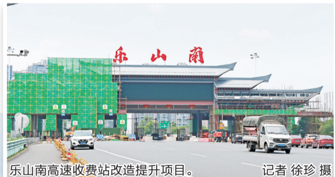
乐山南高速收费站改造提升项目。 记者 徐珍 摄
