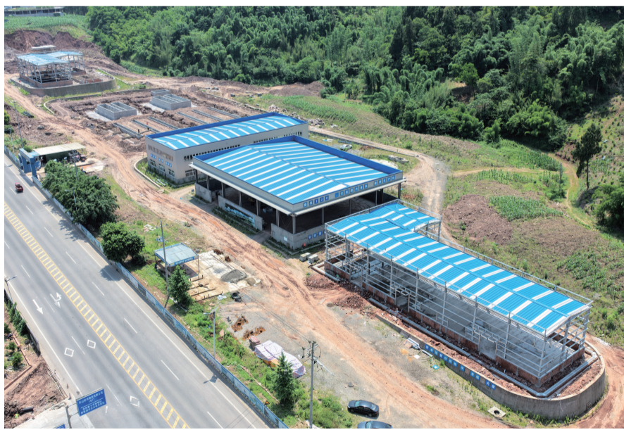
航拍项目建设现场。
