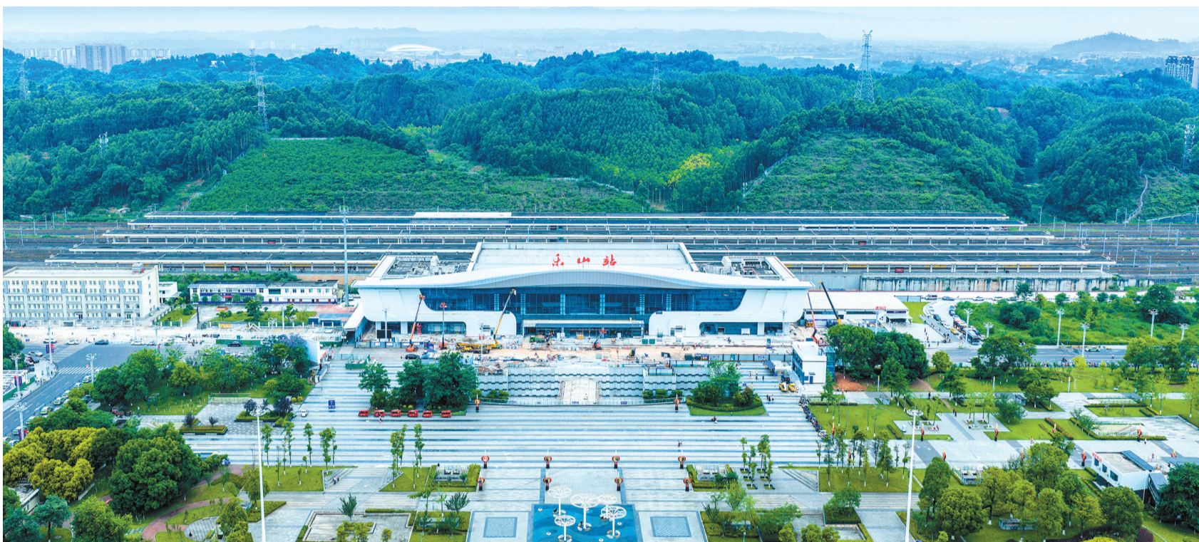
航拍高铁乐山站。
