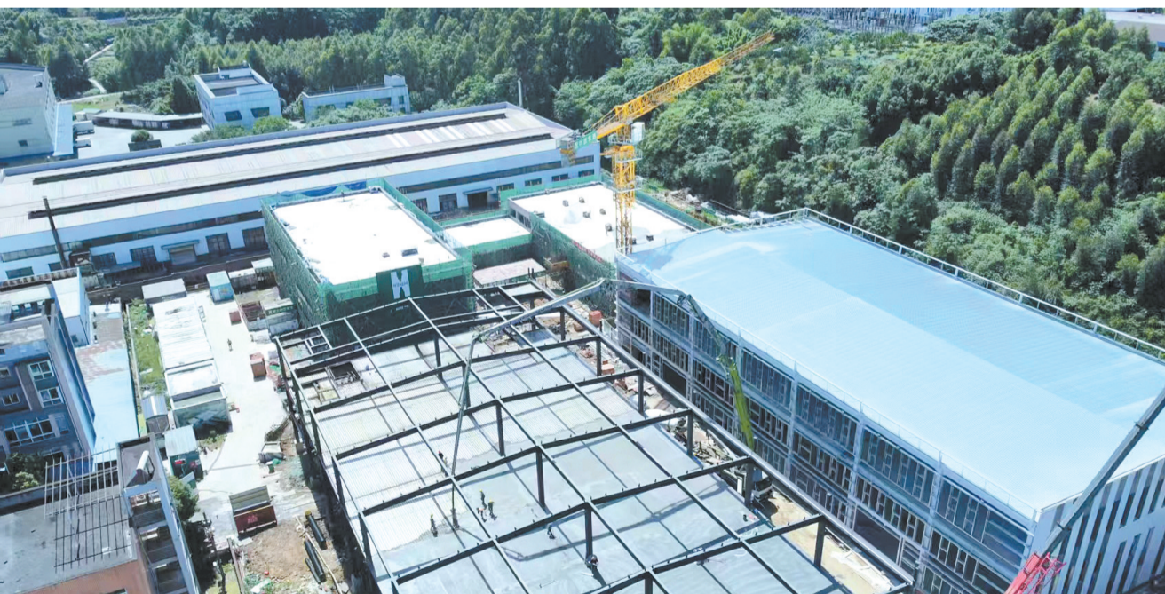
乐山高新区发动机密封组件生产制造基地项目建设现场。
