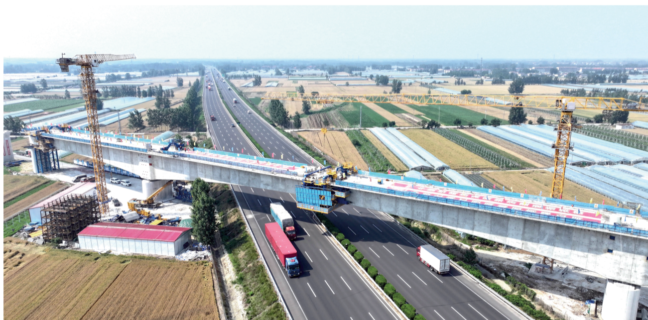
5月31日,由中铁上海局承建的淮(坊)宿(迁)高铁山东省临沂市郯城县段跨京沪高速连续梁顺利合龙,标志着全线重难点控制性工程取得突破性进展,为后续架梁、铺轨作业奠定坚实基础。图为5月31日拍摄的淮宿高铁山东省临沂市郯城县段跨京沪高速连续梁合龙后的画面。新华社记者 郭绪雷 摄
