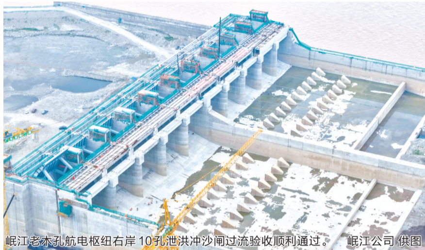
岷江老木孔航电枢纽右岸10孔泄洪冲沙闸过流验收顺利通过。 岷江公司供图
