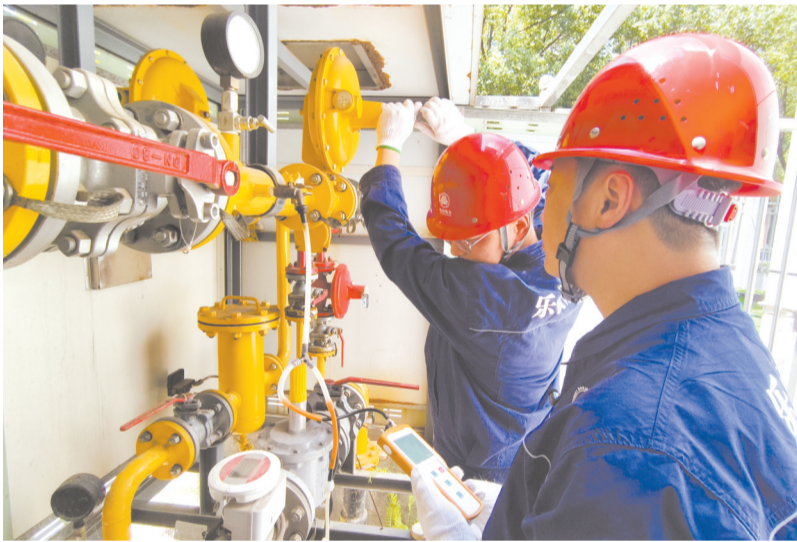
工作人员排查安全隐患。
