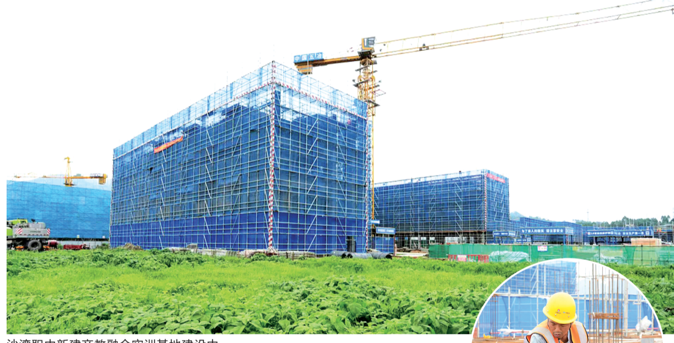
沙湾职中新建产教融合实训基地建设中。
