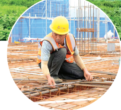
施工人员抓紧施工中。
