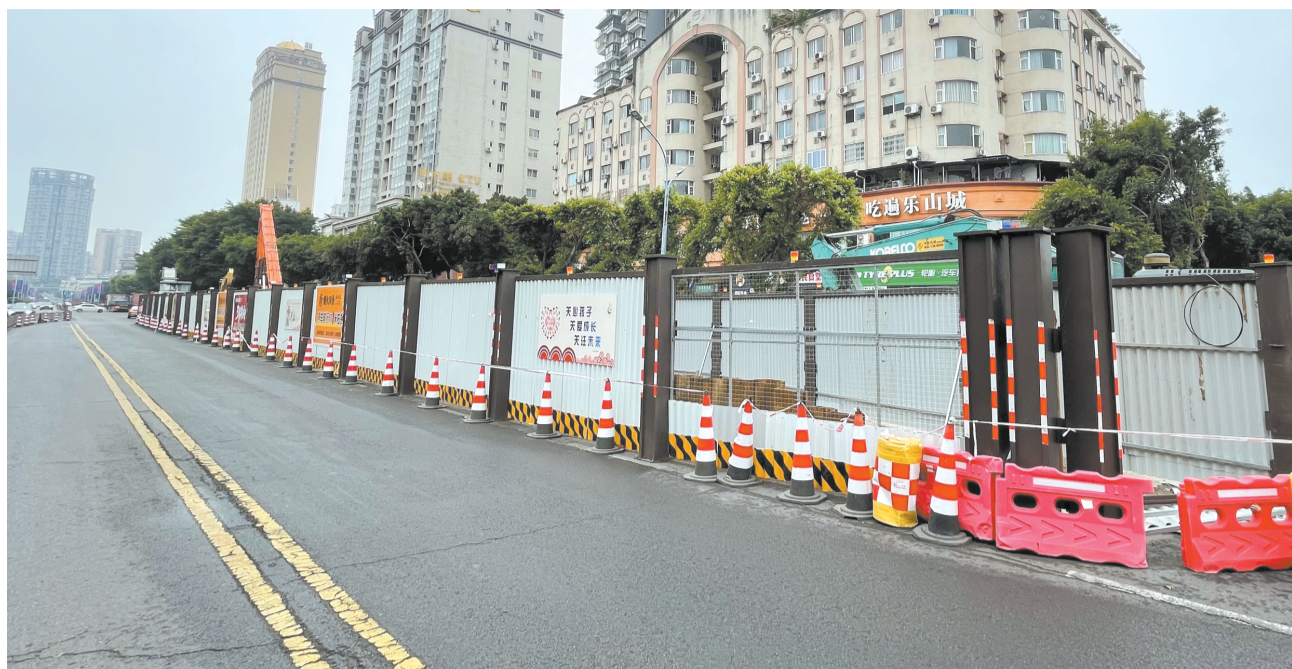
龙游路项目二期打围现场。
