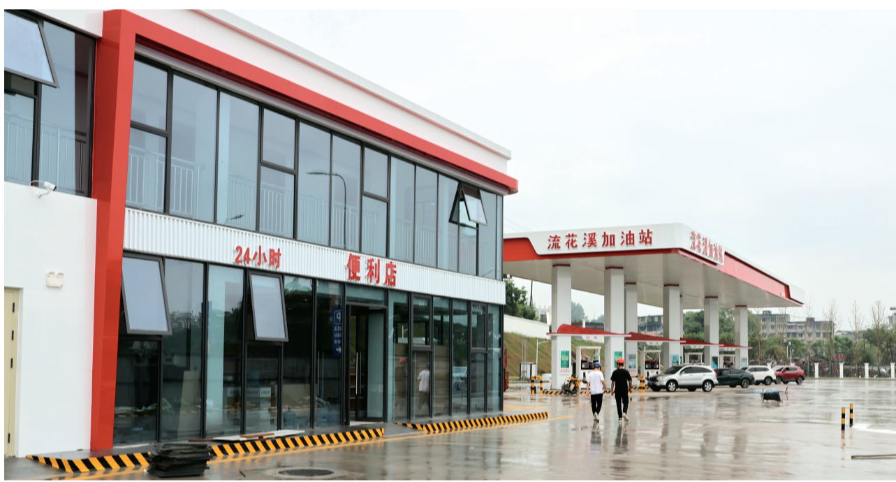
流花溪加油站即将竣工验收。
