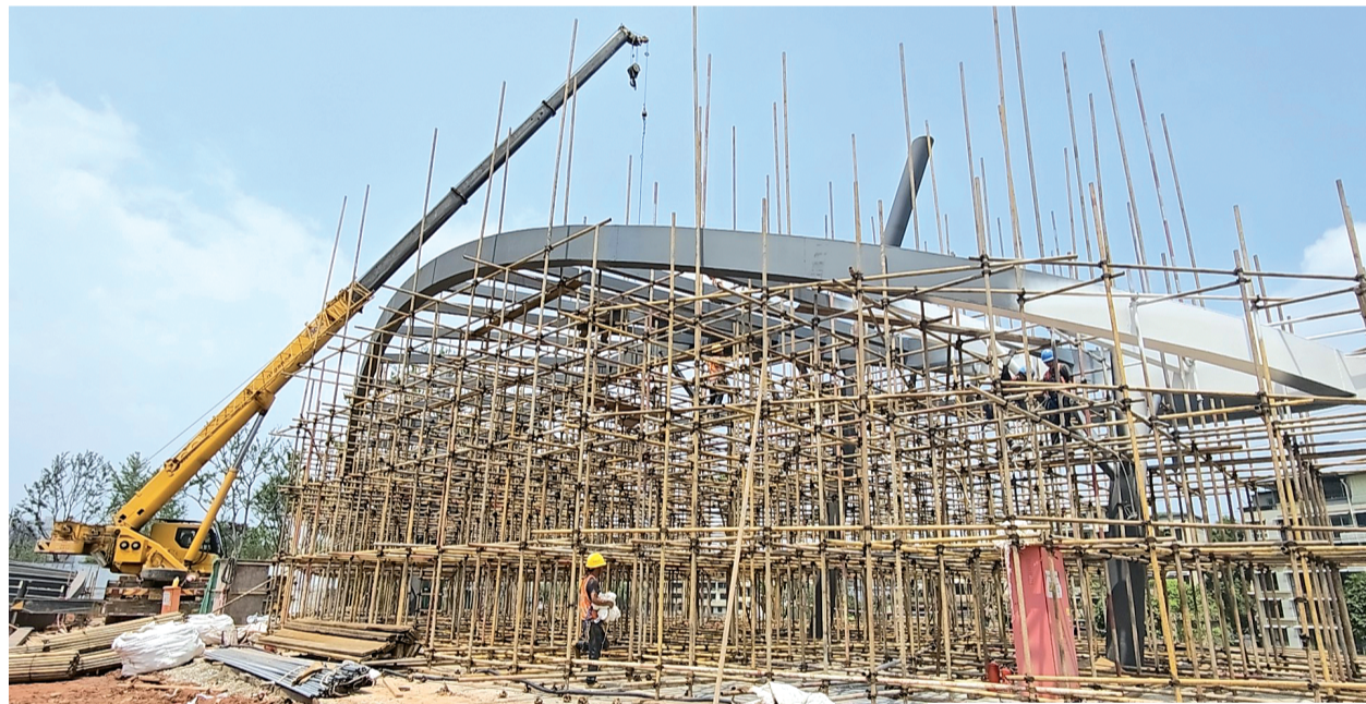
竹叶亭抓紧进行装饰装修。
