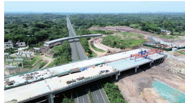
航拍资乐高速公路余家沟大桥。
