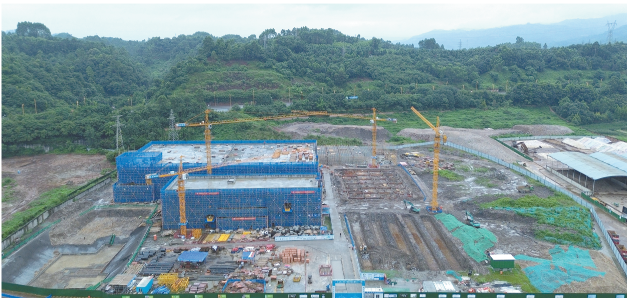
“中药研发中心”完成主体结构封顶。
