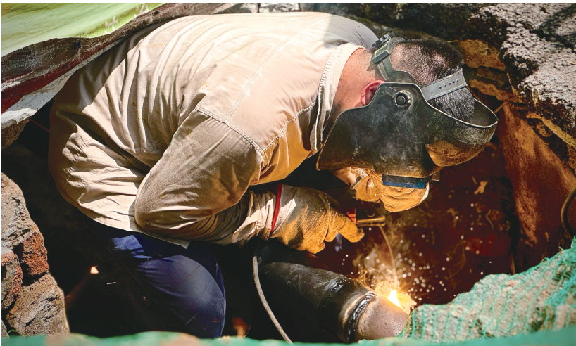
燃气公司运检中心工作人员开展抢险工作。
