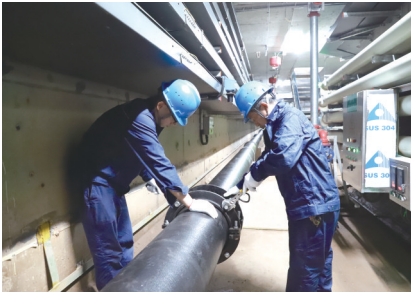
抓紧安装供水管道。
