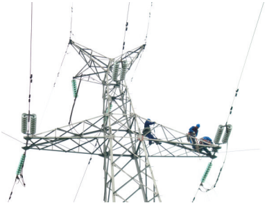
电力人员检修线路。
