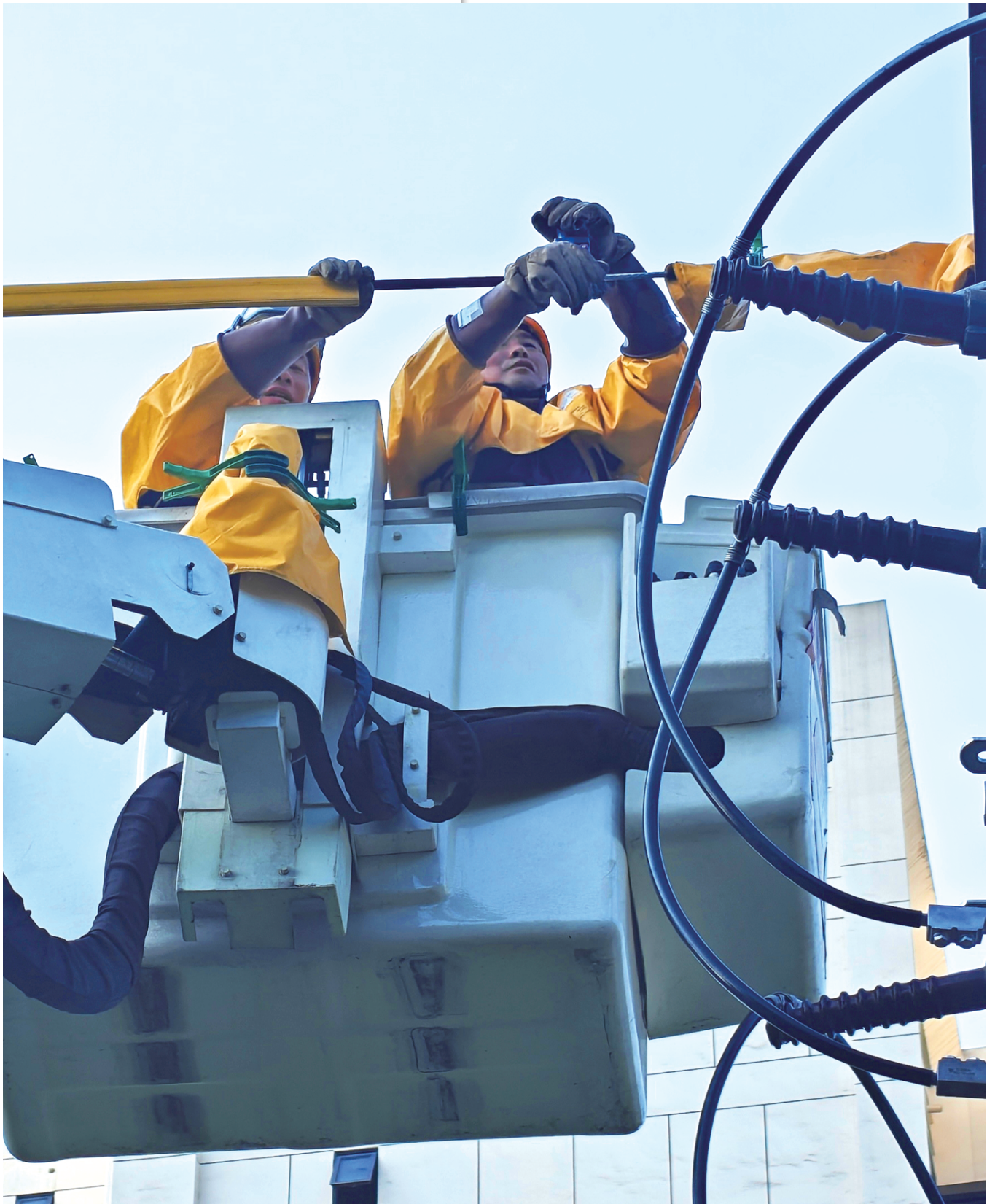
电力工作人员在高温下开展检修。
