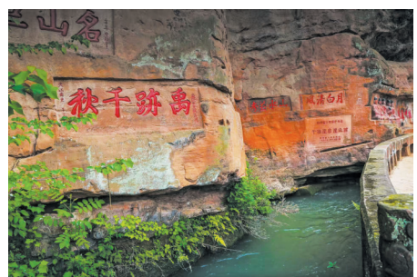
东风堰千佛岩隧洞。
