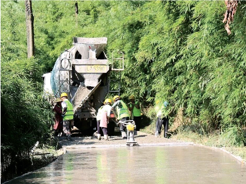
沐川县以工代赈项目建设现场。
