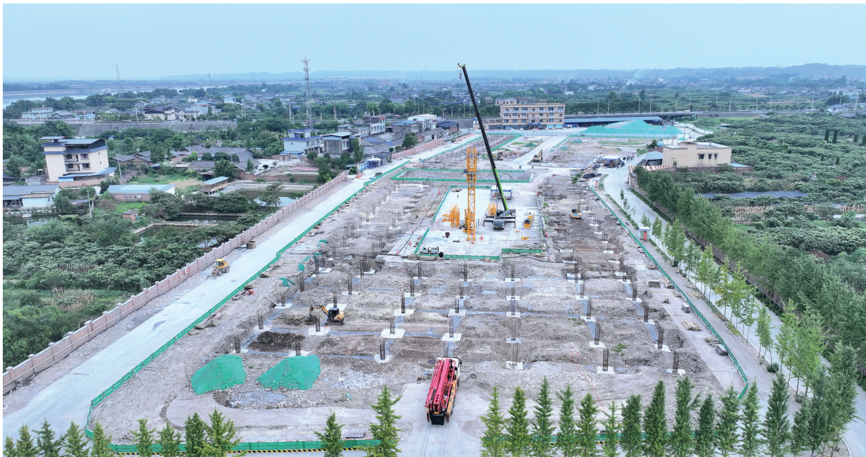
项目建设现场。
