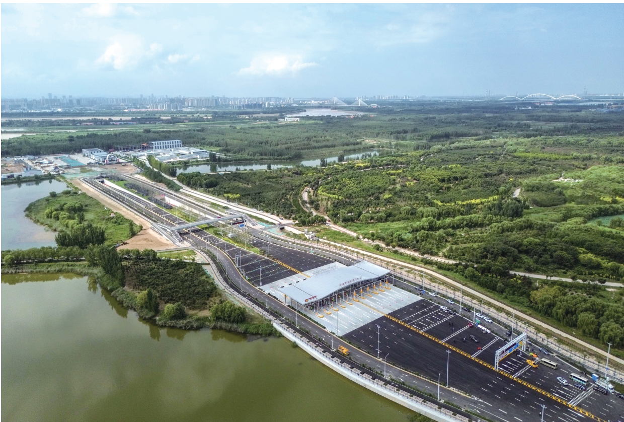
8月25日,由济南城市建设集团投资建设、中铁十四局施工的济南黄岗路黄河隧道建成通车,标志着我国最大直径水下盾构隧道正式投入使用。济南黄岗路黄河隧道全长约5.75公里,其中盾构段长约3.3公里,采用开挖直径达17.5米的“山河号”盾构机施工。隧道为单洞双层结构,上下层共设置六车道,设计时速60公里,是国内首条穿黄单洞双层盾构隧道。图为当日拍摄的济南黄岗路黄河隧道通车现场(无人机照片)。 新华社记者 朱峥 摄
