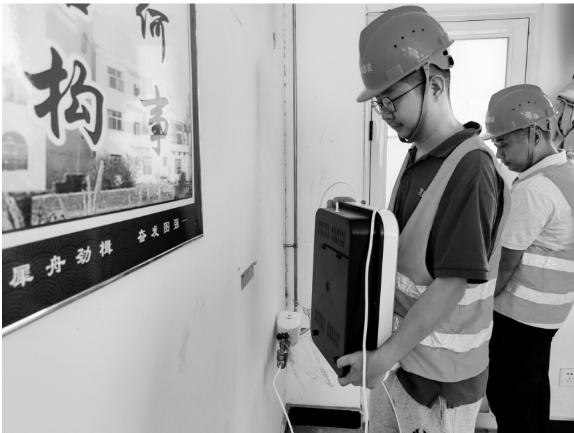
工人安装设备。
