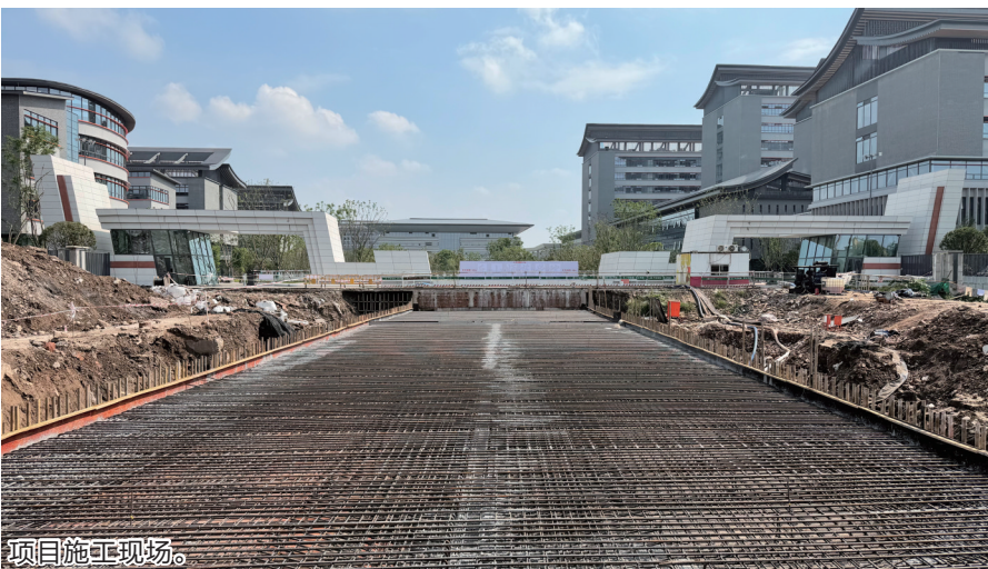
项目施工现场。
