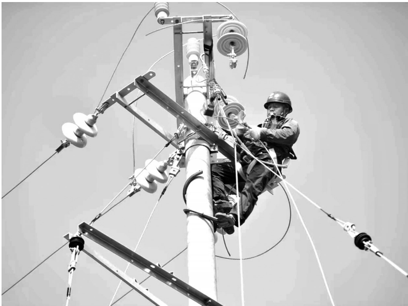
工作人员在铁炉镇施工现场进行杆上展放、绑扎固定架空导线。
