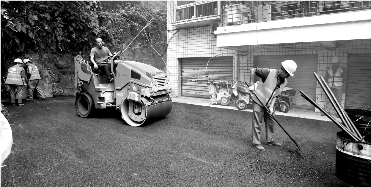
老旧小区改造施工现场。
