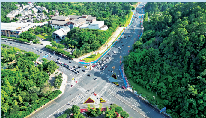
绿心路综合提升改造工程通车。
