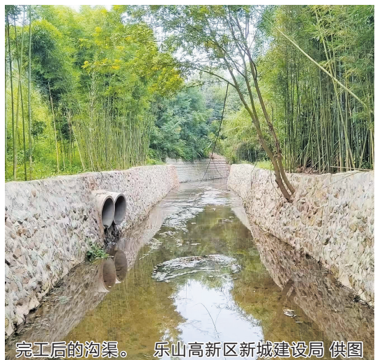
完工后的沟渠。 乐山高新区新城建设局 供图
