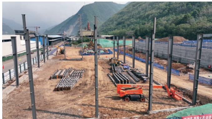
峨边彝族自治县绿色循环产业园基础设施建设项目(五期)现场。
