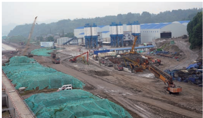
五通桥区岷江东风岩航电枢纽工程加快建设。
