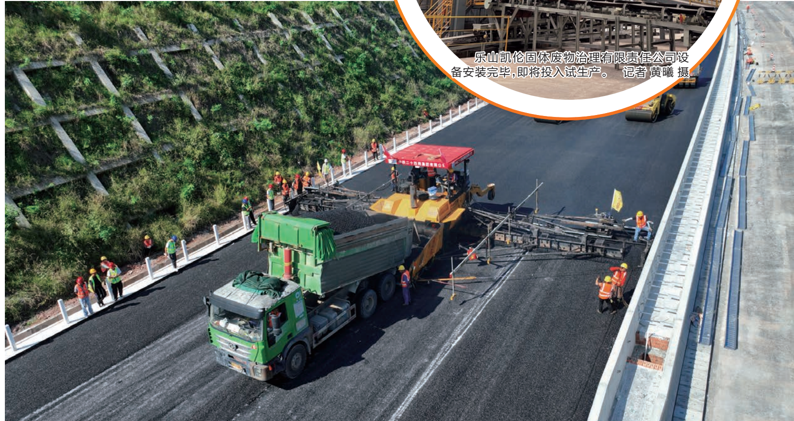
天府新区经眉山至乐山高速公路(天眉乐高速)TJ10标段转入路面施工攻坚阶段。
