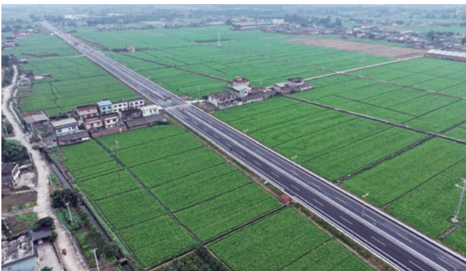
夹江县城区货车绕行一期工程现场。
